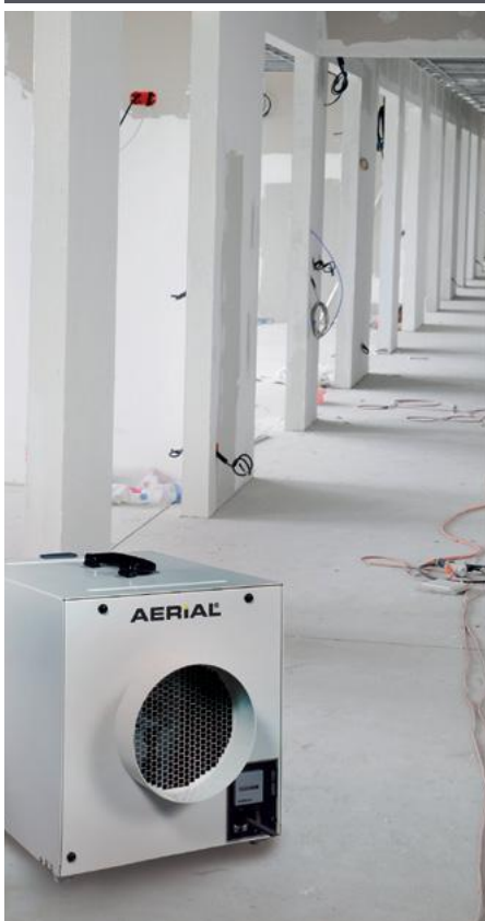
LÜFTER UND LUFTREINIGER
